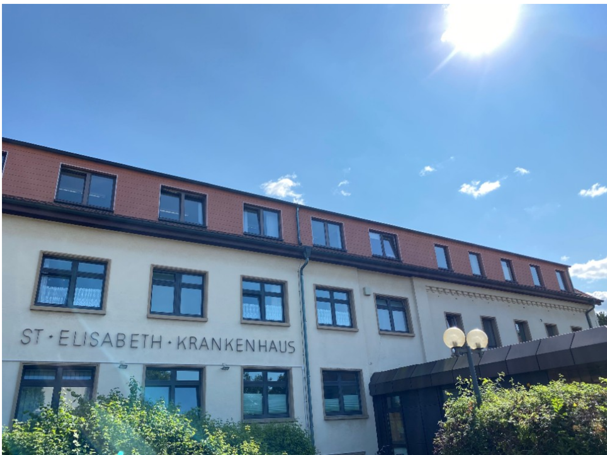
Vorderansicht mit Haupteingang
